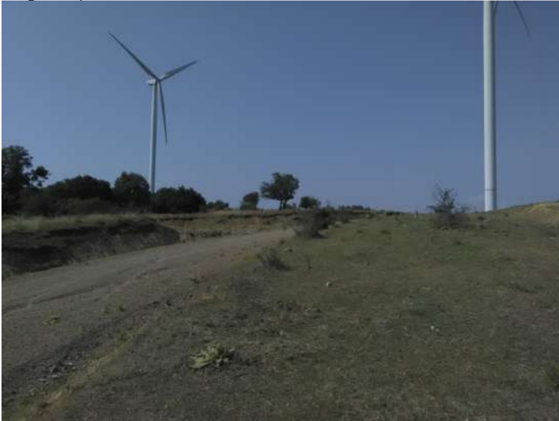
Turbinele eoliene 2 si 3
