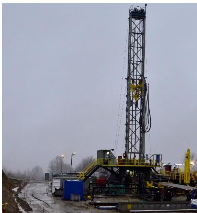
Figura nr. 2-1 Model de instalație de foraj amplasată pe una din locațiile Amromco Energy SRL
