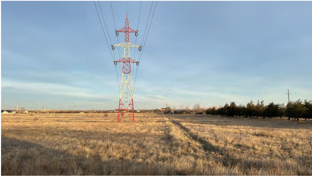
Fig. 39: din zona frontului B-dul Unirii terenului către terenul care a generat PUZ, sursa: proprie
