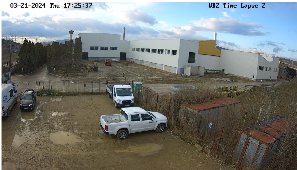
- Vedere externa asupra constructiei
